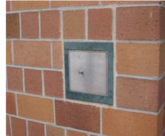
Bild: Feuerwehr-Schlüsseldepot
